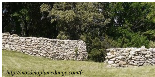
Mur de clôture
