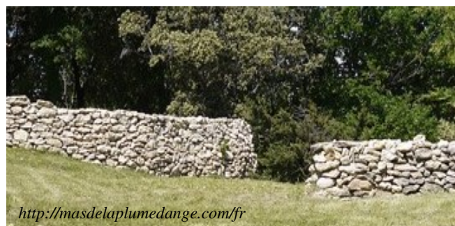
Mur de clôture
