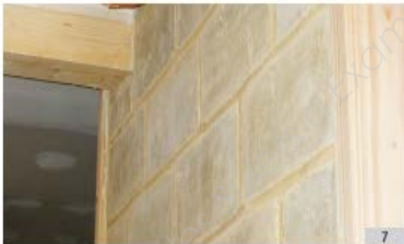
Mur en briques de terre crue
