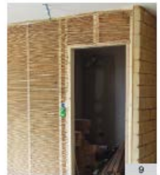
Cloison bois, canisse et terre
